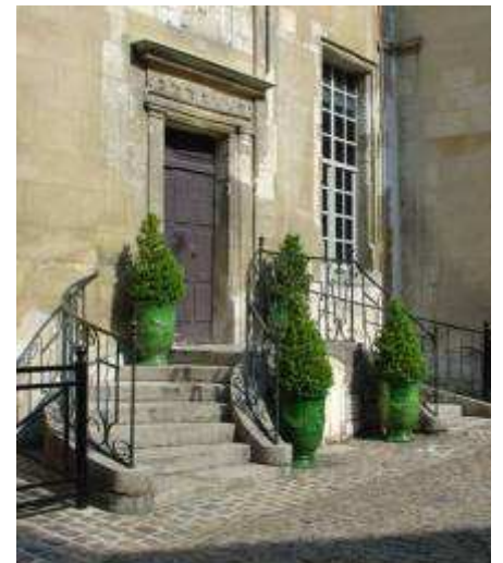
Vue du perron avant restauration
