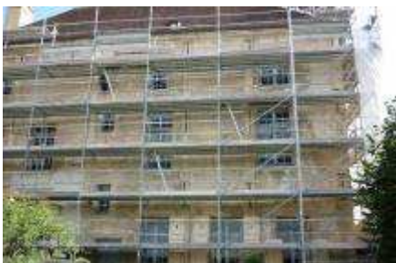
Mise en place des échafaudages côté jardin
